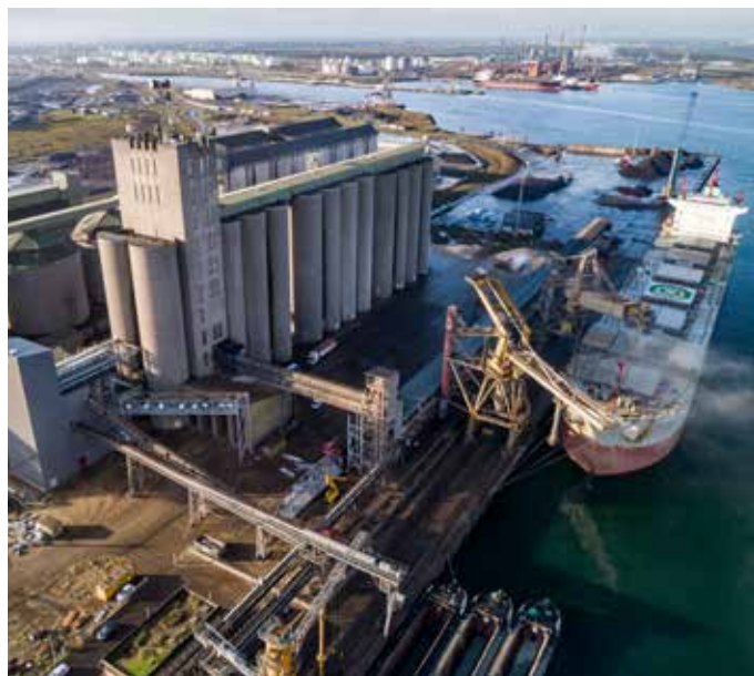
→ Aujourd'hui, le site dispose d'une capacité de stockage de 330 000 t.
