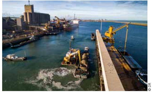
→ Le futur silo sera construit sur la darse, actuellement en cours de comblement.
