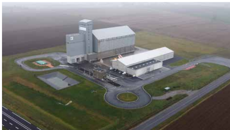
→ Le silo vertical est destiné à recevoir les différents grains de collecte, tandis que le silo à plat accueille une ligne pour la fabrication et l'ensachage du bulk.
