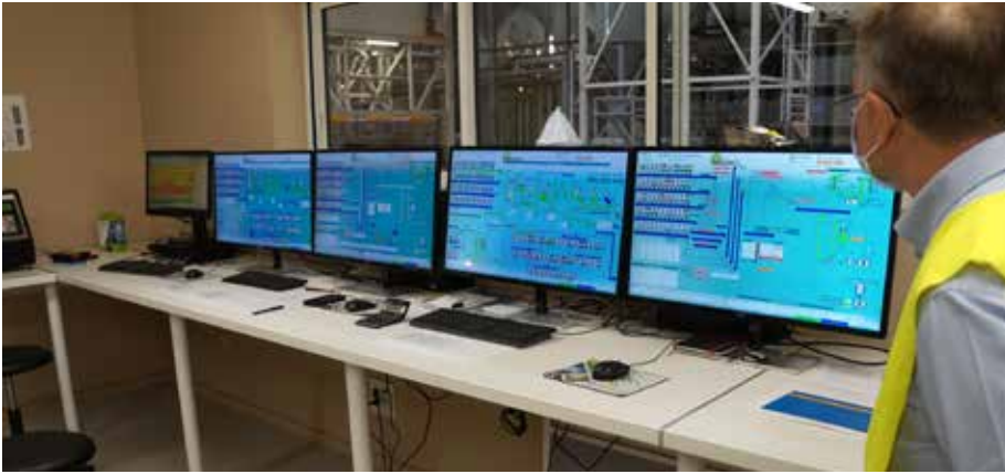
→ Au poste de supervision, le logiciel de pilotage « Nutriciel » transmet et reçoit des informations du terrain grâce à la technologie AS-i.
