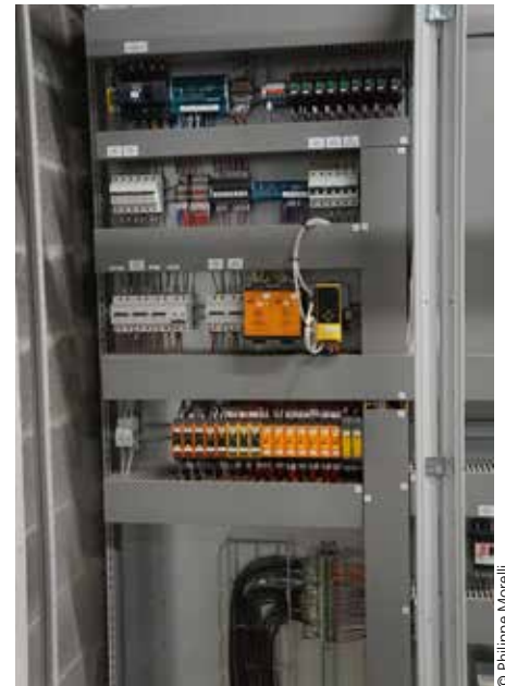
→ Cette armoire électrique accueille un « maître AS-i », centre d'un « système nerveux » dont les terminaisons sont les capteurs et actionneurs.
