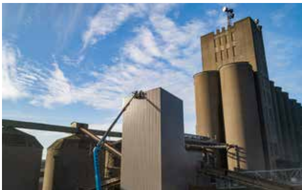
→ Nord Céréales a construit en 2021 une nouvelle tour PAD pour lutter contre les risques d'exploitation et assurer la croissance de l'activité.
